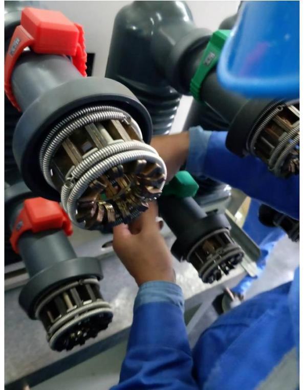
移开式高压开关柜：母排， 静触头， 电缆搭接等部位。
